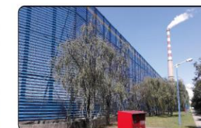
электростанция в Цзяоцзо
