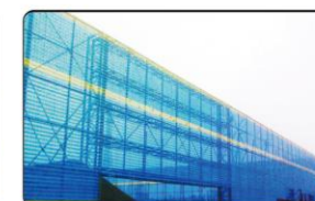
электростанция в Жуйцзинь
