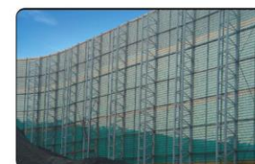
электростанция в Дандуне
