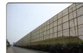
электростанция в Чаоху
